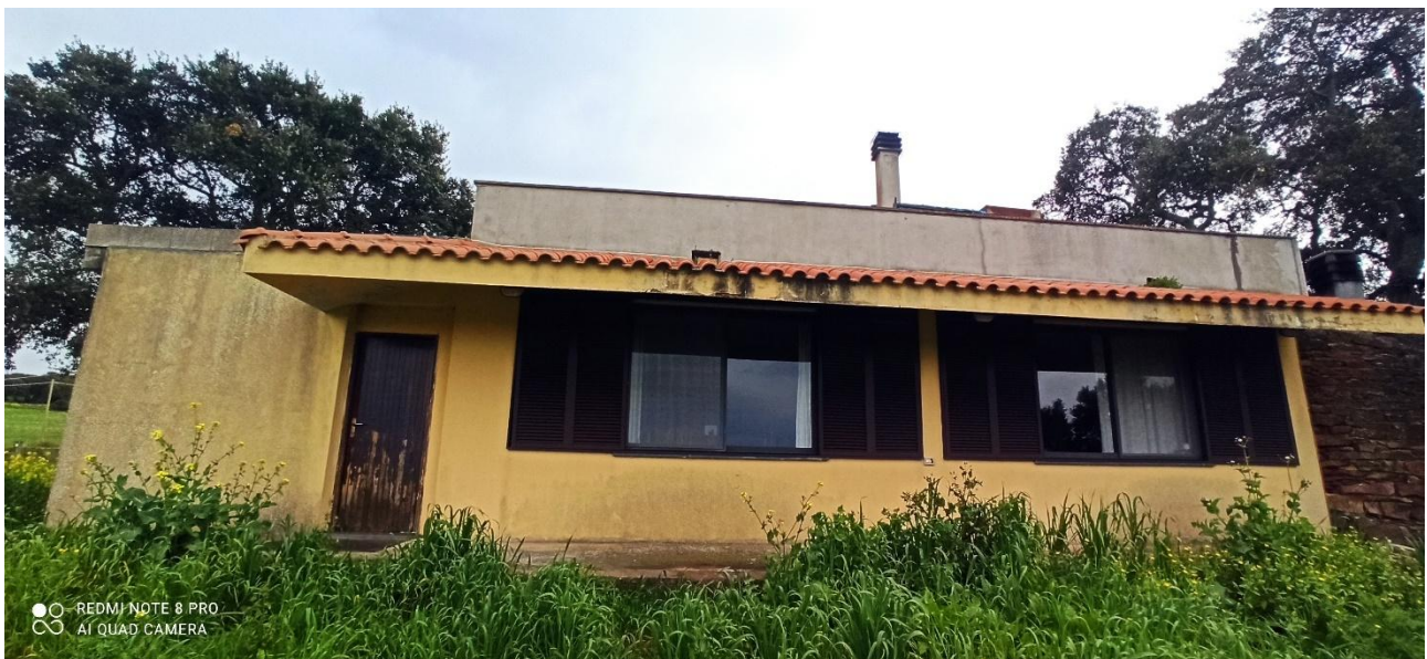
Foto n.4 – prospetto est dell'edificio a destinazione residenziale indicato con A nell'ortofoto, vista esterna
