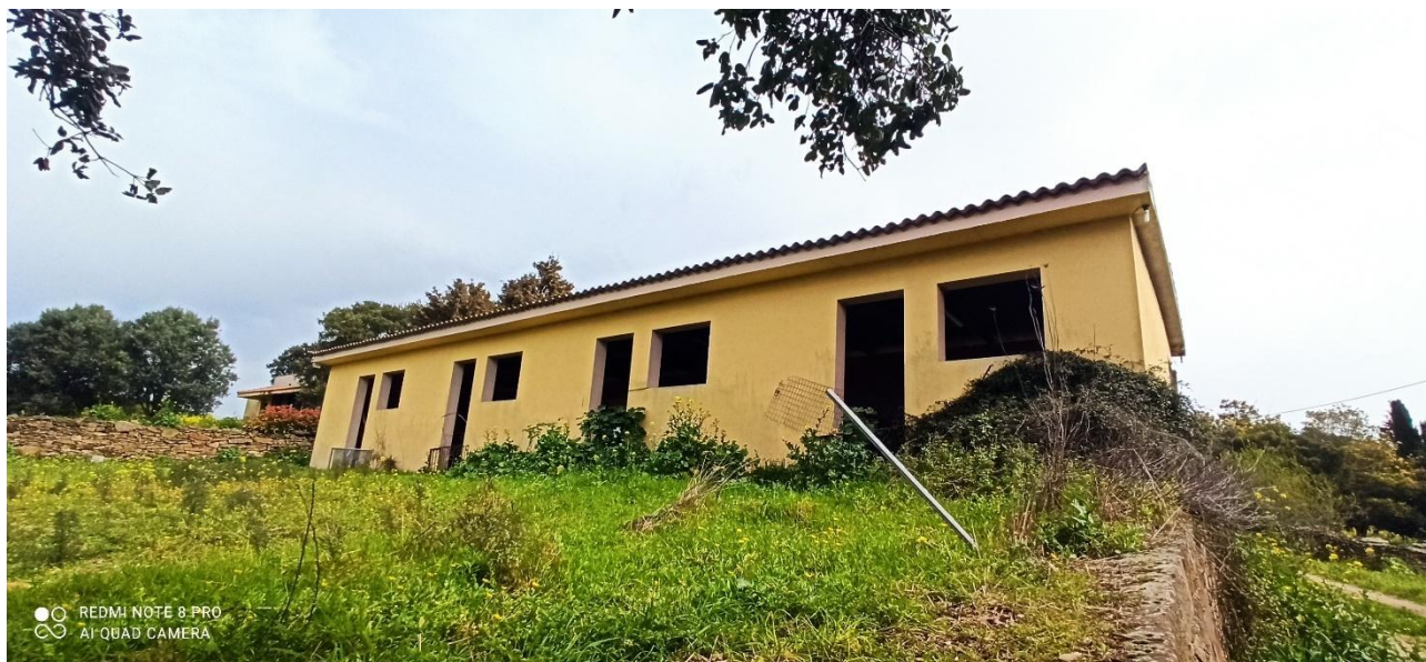
Foto n.55 – prospetto est dell'edificio a destinazione scuderia indicato con B nell'ortofoto, vista esterna
