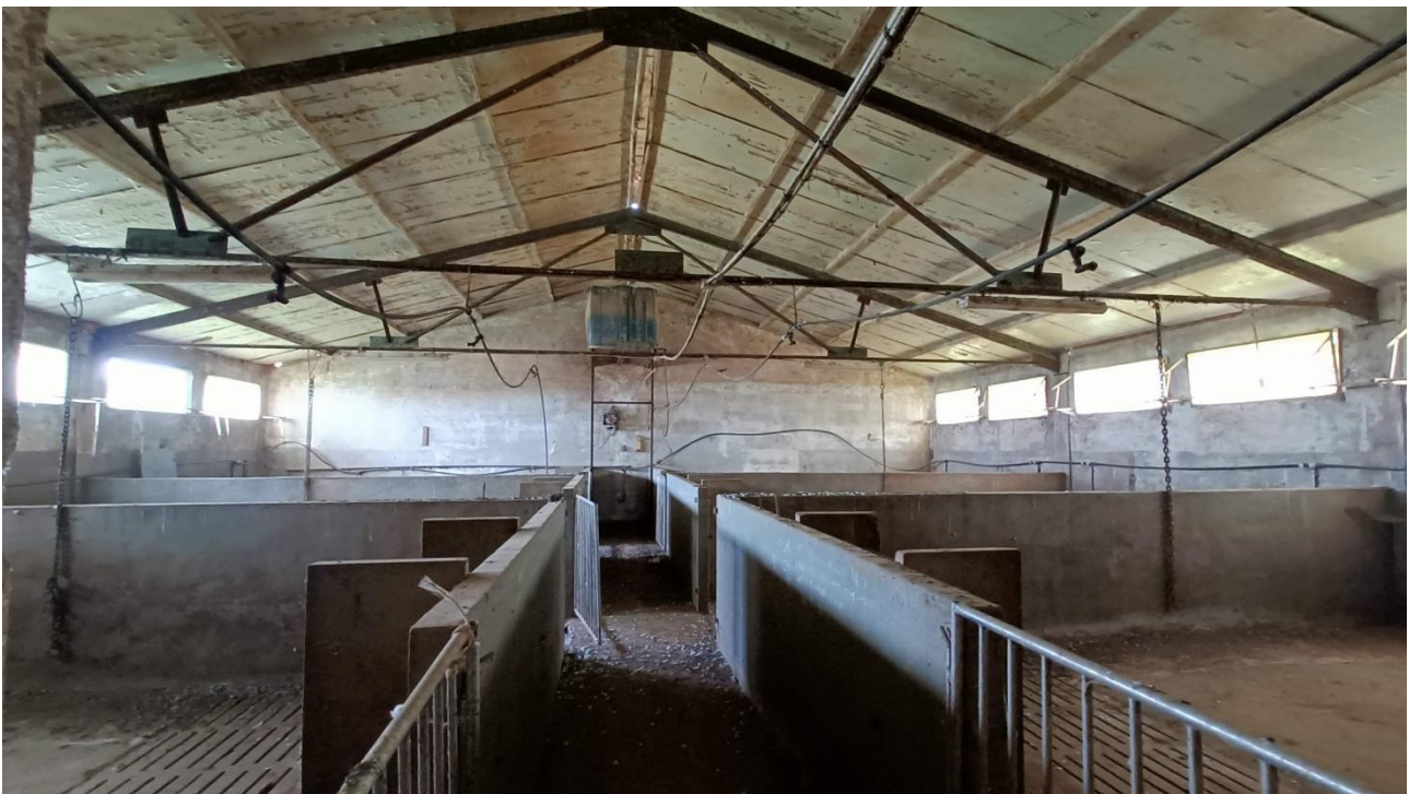
Foto n.72 edificio a destinazione stalla indicato con D nell'ortofoto, vista interna
