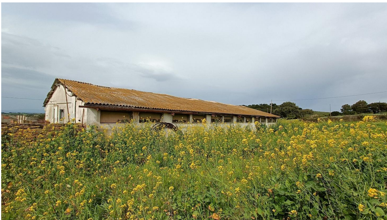
Foto n.61 edificio a destinazione stalla indicato con C nell'ortofoto, vista esterna
