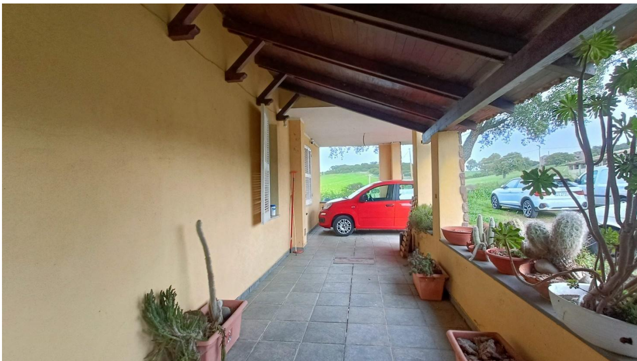
Foto n.8 – edificio a destinazione residenziale indicato con A nell'ortofoto, vista portico lato ovest
