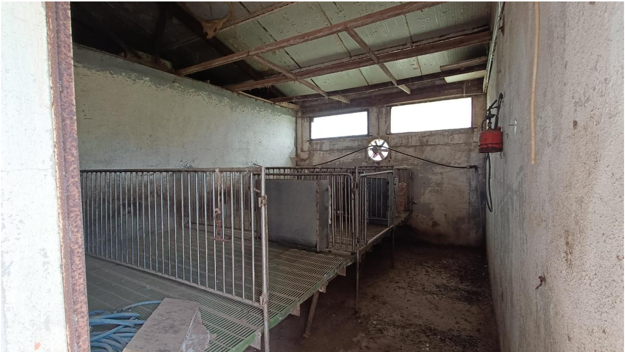
Foto n.71 edificio a destinazione stalla indicato con D nell'ortofoto, vista interna
