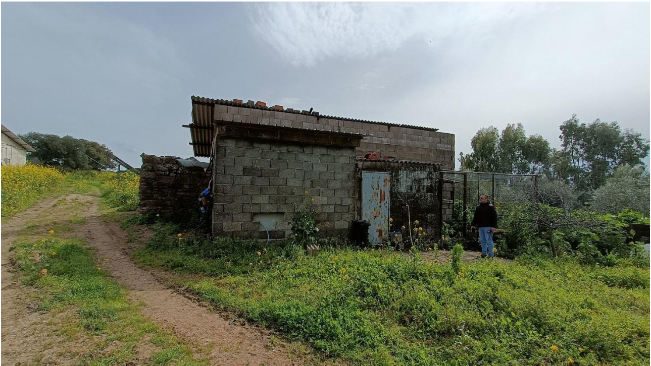
Foto n.65 edificio a destinazione stalla indicato con E nell'ortofoto, vista esterna
