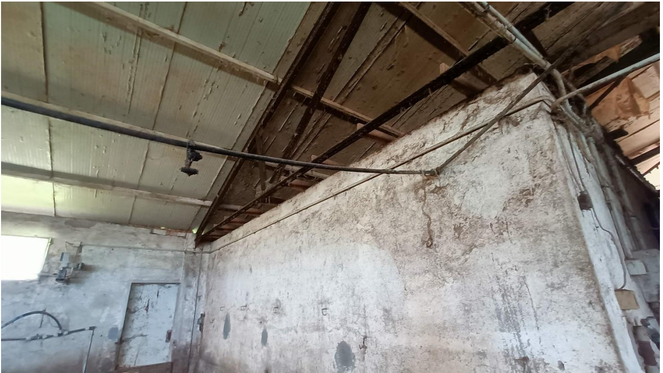
Foto n.75 edificio a destinazione stalla indicato con D nell'ortofoto, vista interna
