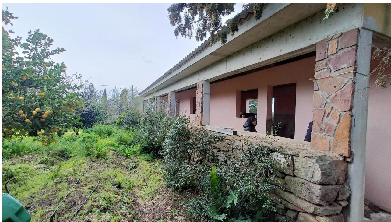
Foto n.54 – prospetto ovest dell'edificio a destinazione scuderia indicato con B nell'ortofoto, vista esterna
