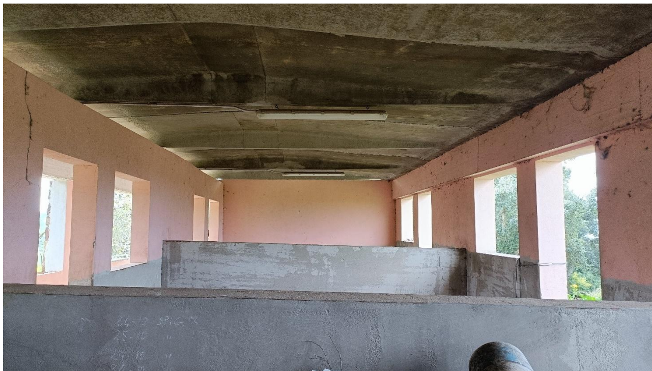
Foto n.57 vista interna dell'edificio a destinazione scuderia indicato con B nell'ortofoto, stalle
