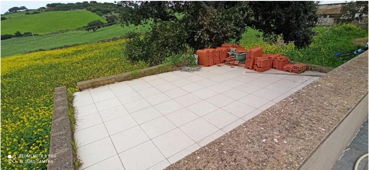
Foto n.52 – edificio a destinazione residenziale indicato con A nell'ortofoto, vista terrazzo, dettaglio lastrico dell'ampliamento (rif. 33 in pianta)
