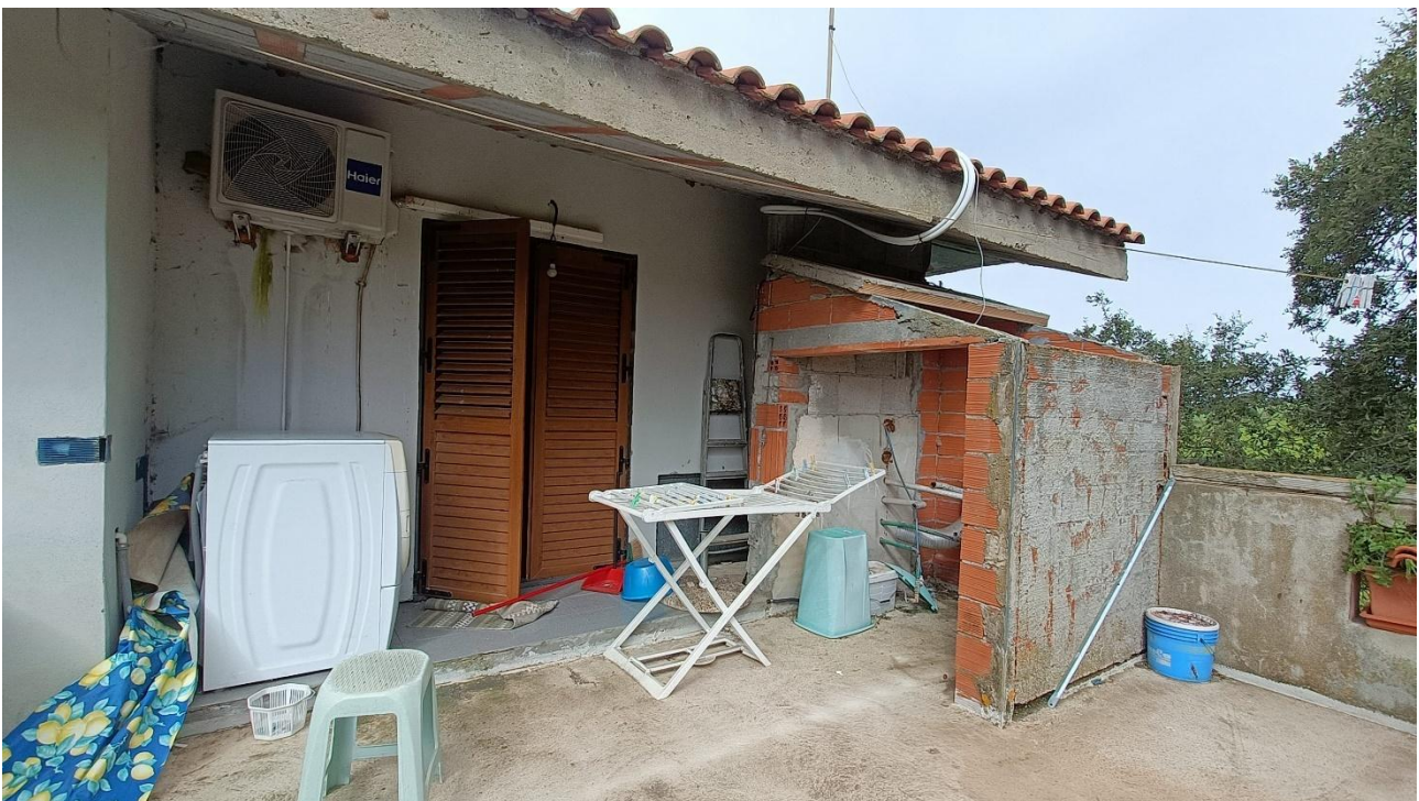
Foto n.31 – edificio a destinazione residenziale indicato con A nell'ortofoto, vista terrazzo (rif. 32 in pianta)
