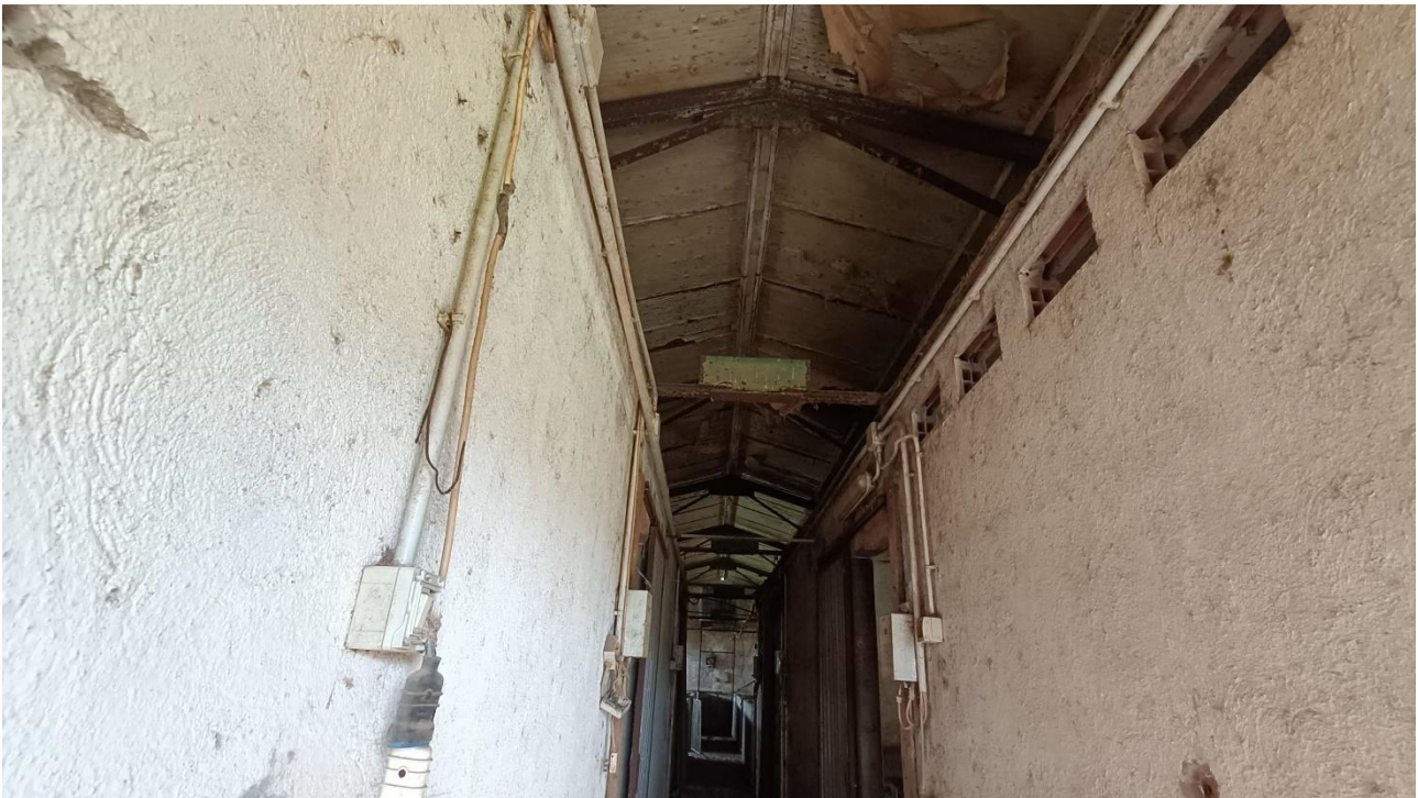
Foto n.70 edificio a destinazione stalla indicato con D nell'ortofoto, vista corridoio interno
