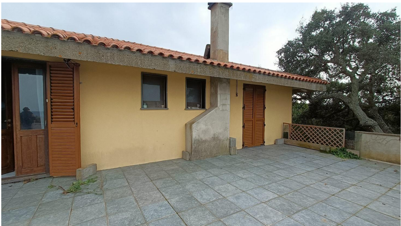
Foto n.51 – edificio a destinazione residenziale indicato con A nell'ortofoto, vista terrazzo (rif. 33 in pianta)
