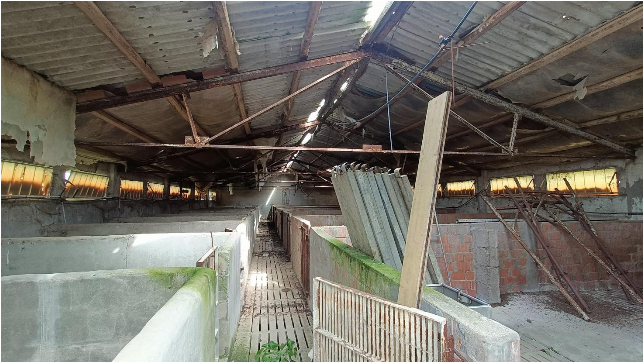
Foto n.62 edificio a destinazione stalla indicato con C nell'ortofoto, vista interna
