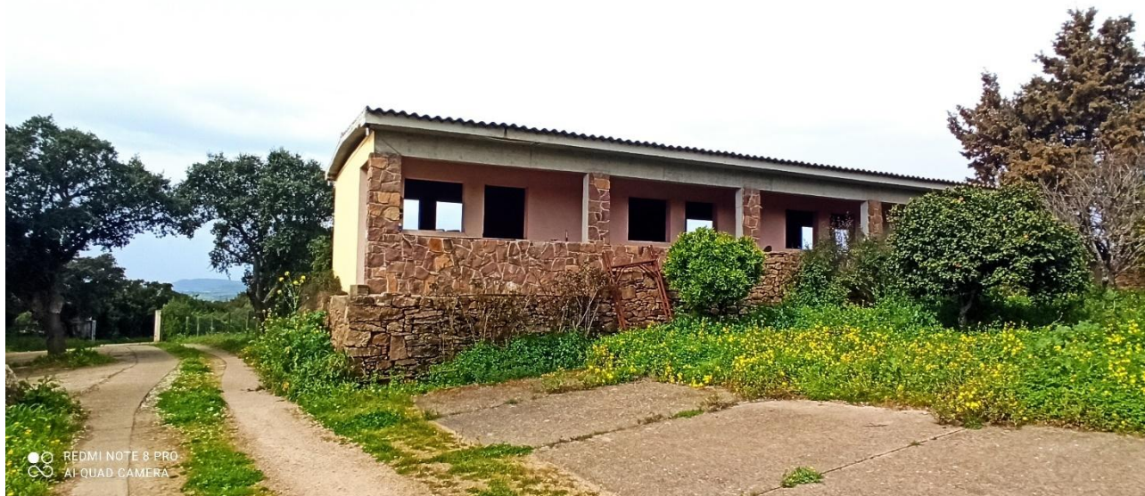
Foto n.53 – prospetto sud-ovest dell'edificio a destinazione scuderia indicato con B nell'ortofoto, vista esterna
