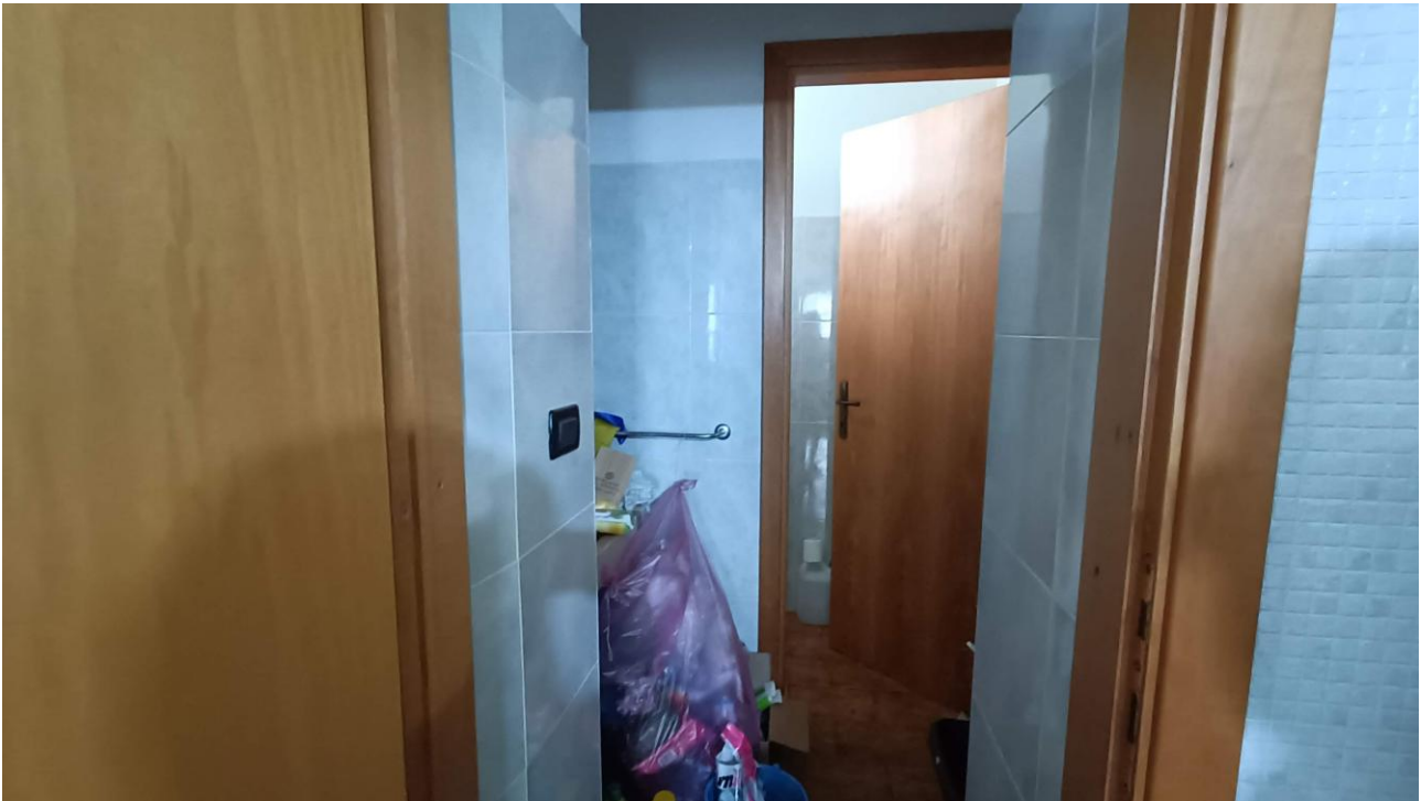
Foto n.17 – edificio a destinazione residenziale indicato con A nell'ortofoto, vista bagno (rif. 10 in pianta)
