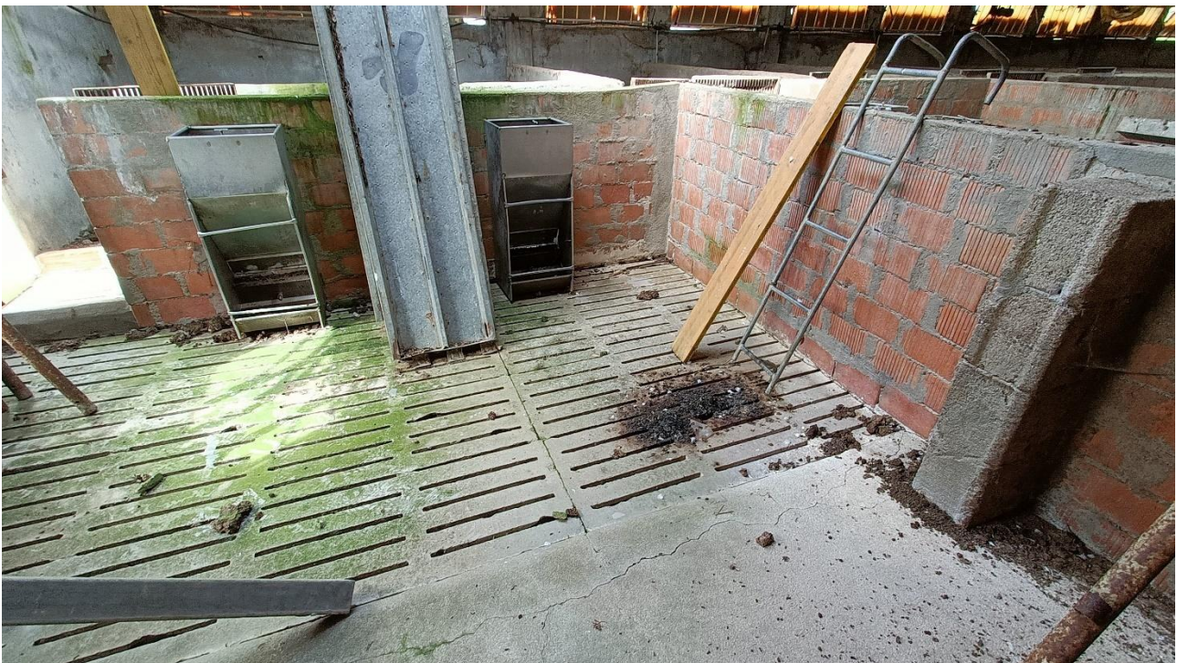
Foto n.63 edificio a destinazione stalla indicato con C nell'ortofoto, vista interna
