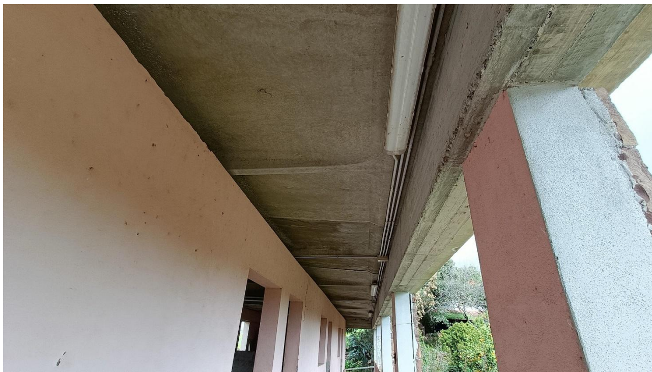
Foto n.58 vista interna dell'edificio a destinazione scuderia indicato con B nell'ortofoto, corridoio, dettaglio copertura
