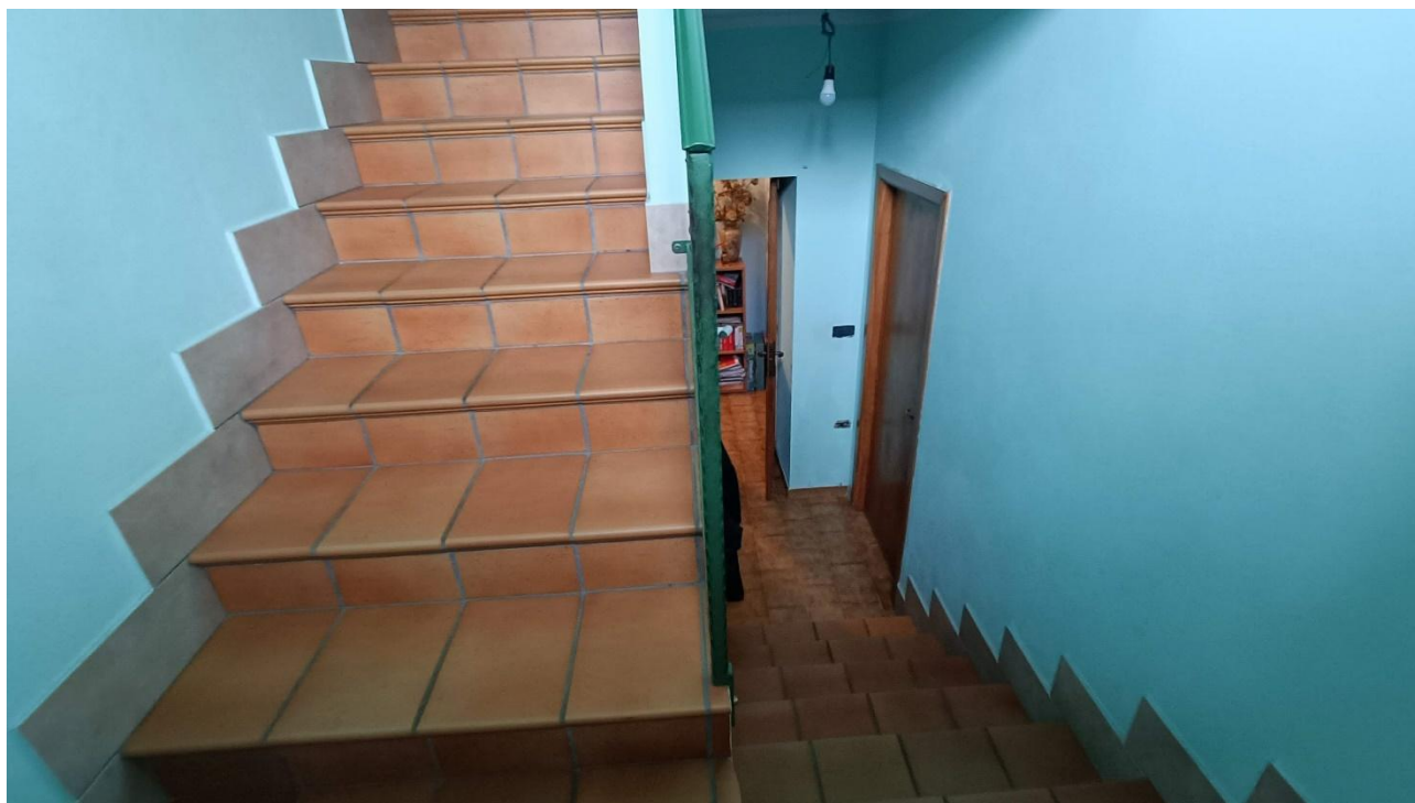
Foto n.26 – edificio a destinazione residenziale indicato con A nell'ortofoto, vista vano scala (rif. 13 in pianta)
