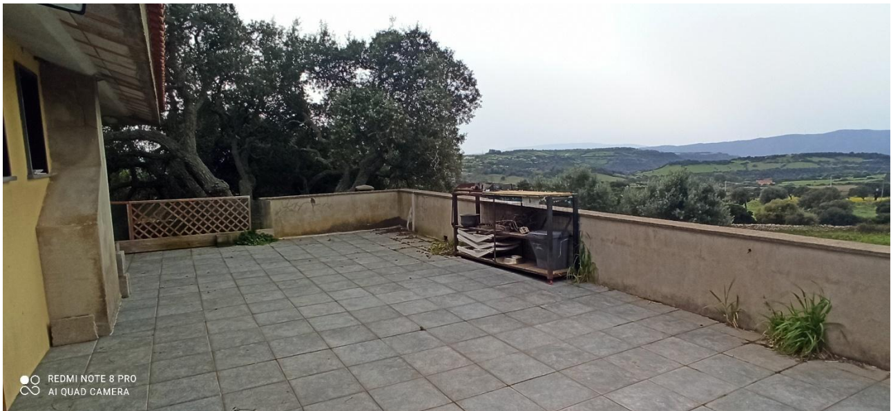
Foto n.50 – edificio a destinazione residenziale indicato con A nell'ortofoto, vista terrazzo (rif. 33 in pianta)
