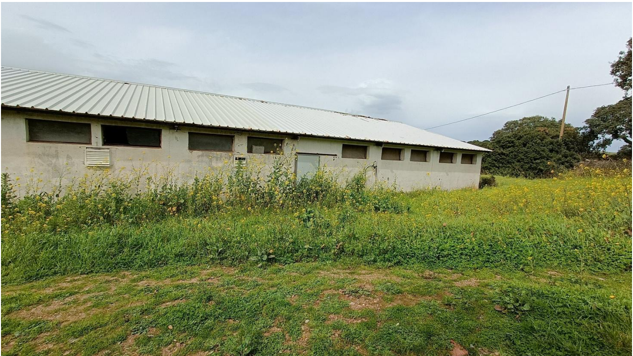
Foto n.69 edificio a destinazione stalla indicato con D nell'ortofoto, vista esterna
