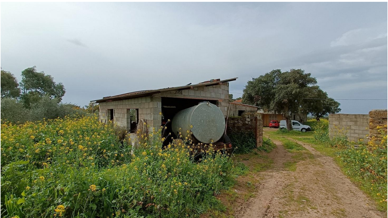
Foto n.66 edificio a destinazione stalla indicato con E nell'ortofoto, vista esterna
