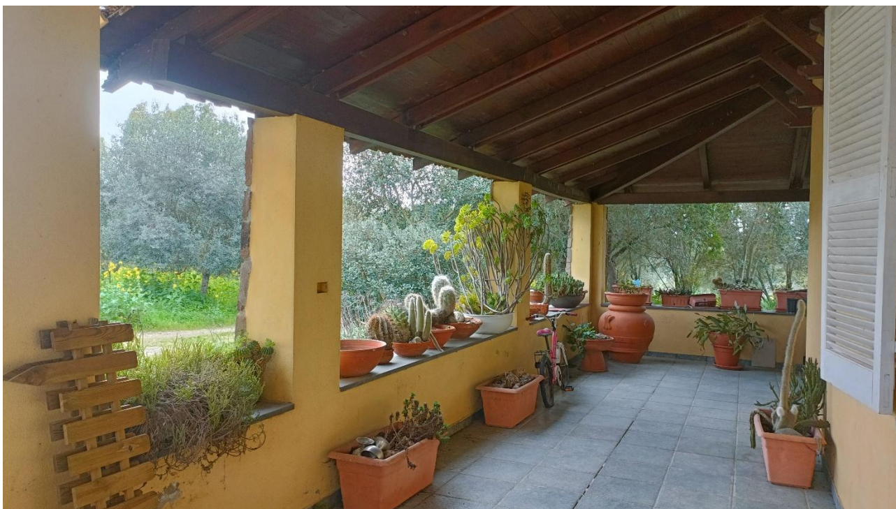
Foto n.7 – edificio a destinazione residenziale indicato con A nell'ortofoto, vista portico lato ovest
