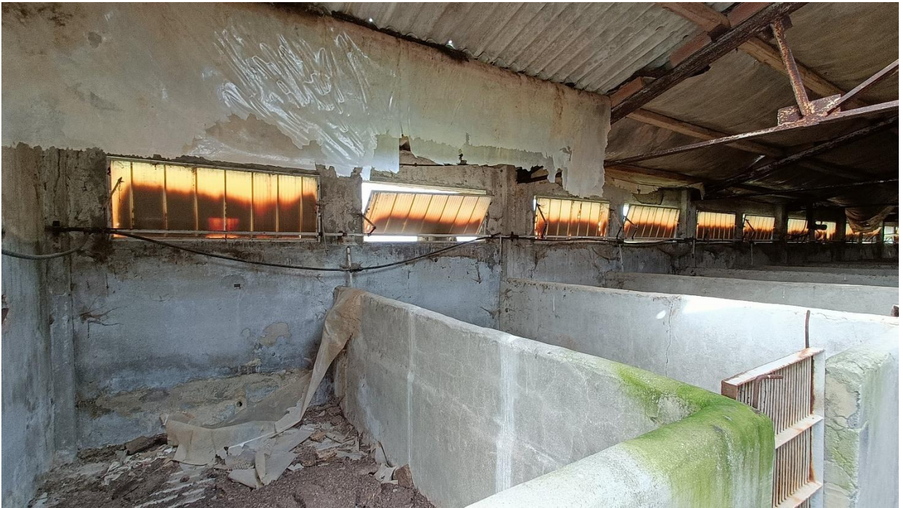
Foto n.64 edificio a destinazione stalla indicato con C nell'ortofoto, vista interna
