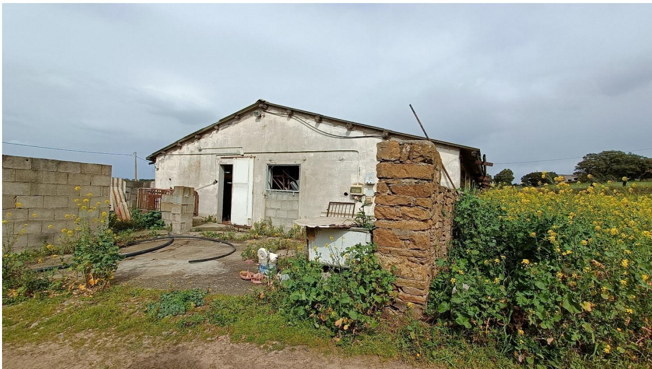
Foto n.60 edificio a destinazione stalla indicato con C nell'ortofoto, vista esterna
