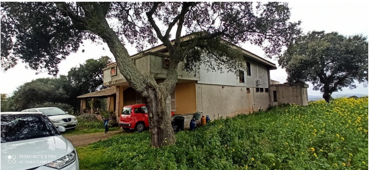
Foto n.2 – prospetto nord e ovest dell'edificio a destinazione residenziale indicato con A nell'ortofoto, vista esterna
