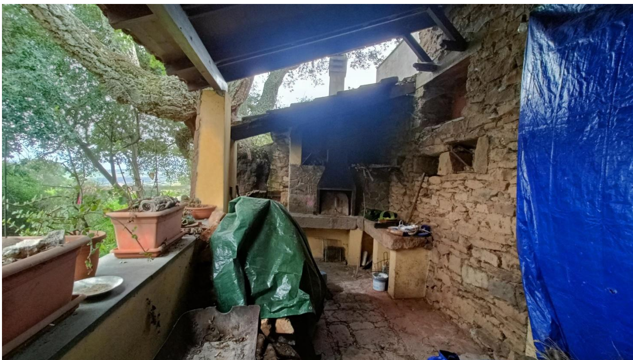
Foto n.6 – edificio a destinazione residenziale indicato con A nell'ortofoto, vista forno all'angolo portico lato sud
