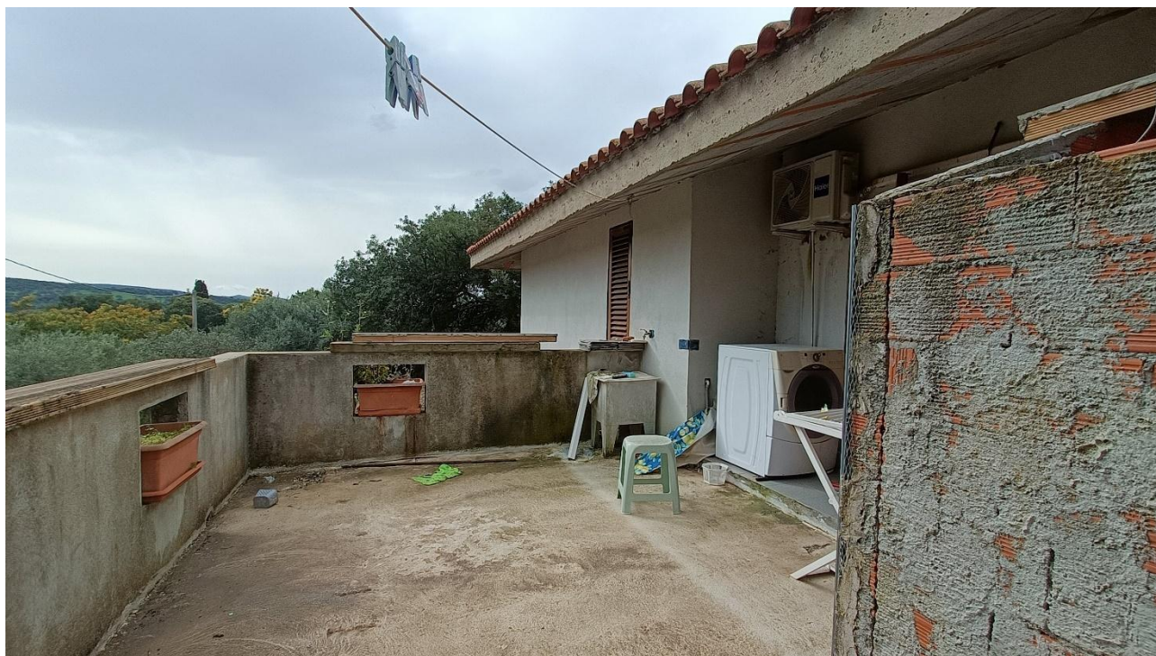
Foto n.32 – edificio a destinazione residenziale indicato con A nell'ortofoto, vista terrazzo (rif. 32 in pianta)
