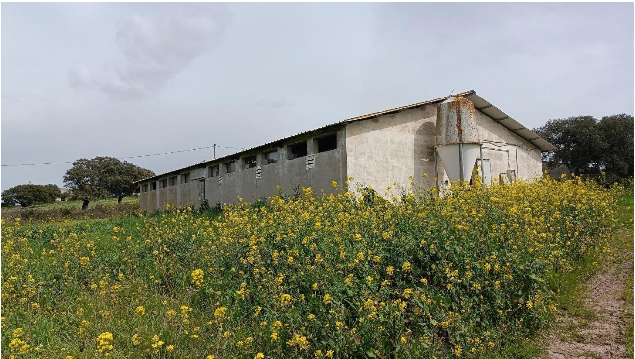
Foto n.68 edificio a destinazione stalla indicato con D nell'ortofoto, vista esterna
