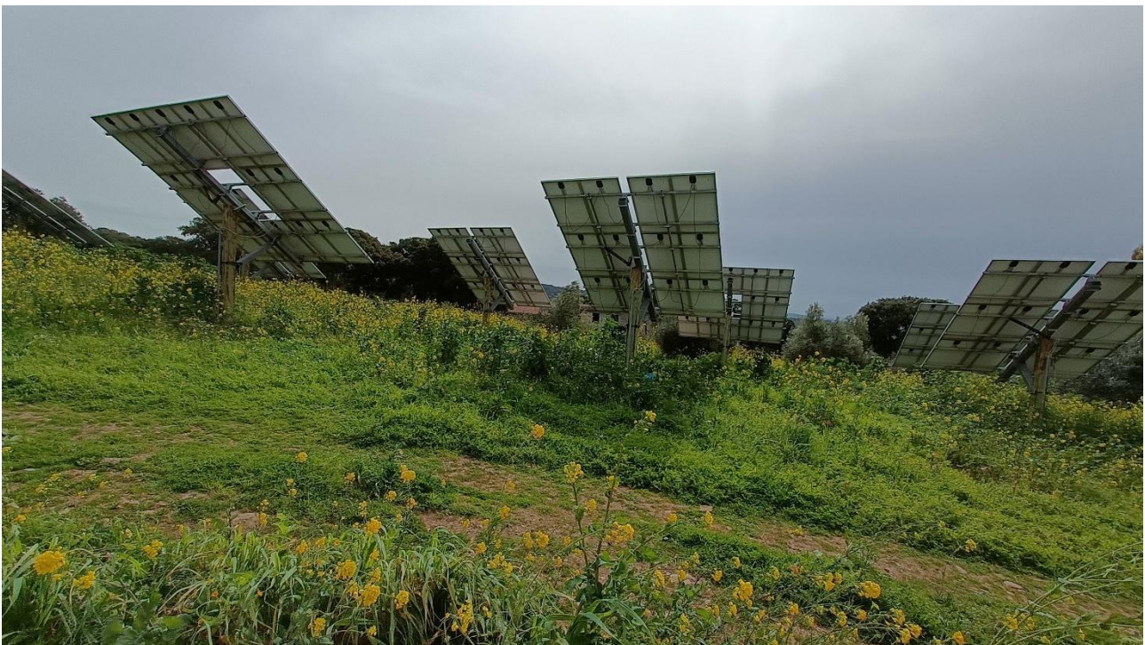
Foto n.83 vista pannelli fotovoltaici zona sud-ovest
