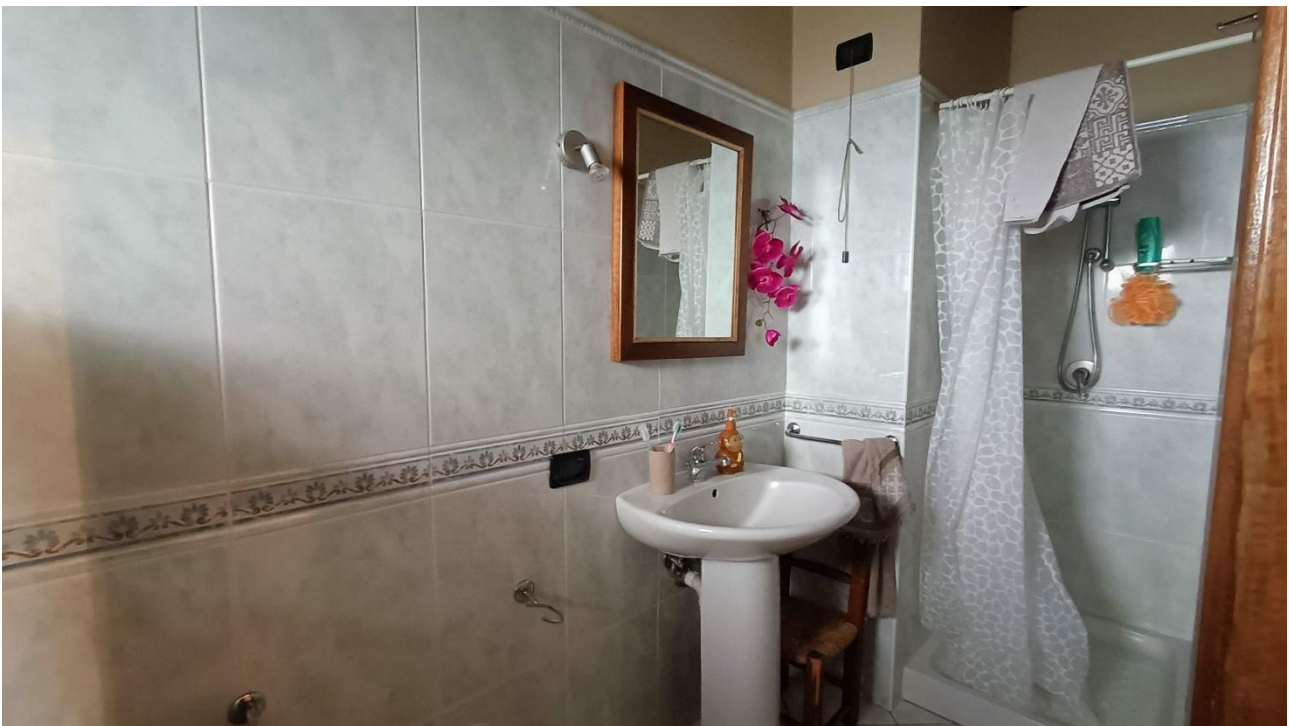
Foto n.49 – edificio a destinazione residenziale indicato con A nell'ortofoto, vista bagno (rif. 23 in pianta)
