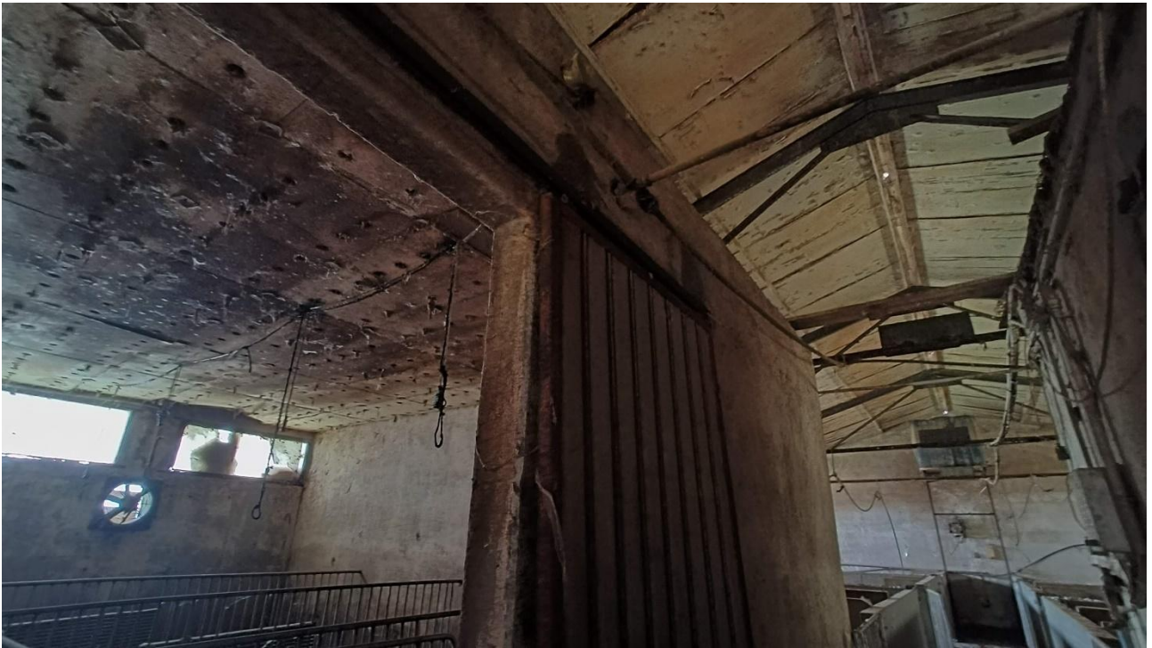
Foto n.73 edificio a destinazione stalla indicato con D nell'ortofoto, vista interna
