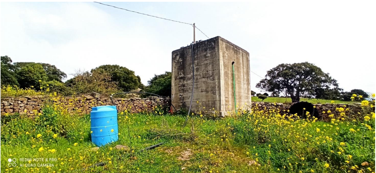
Foto n.81 cisterna presso confine est
