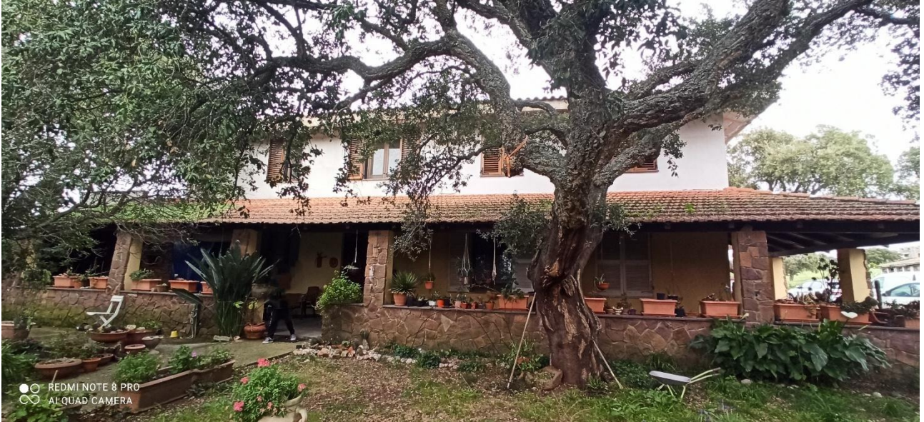
Foto n.1 – prospetto sud dell'edificio a destinazione residenziale indicato con A nell'ortofoto, vista esterna
