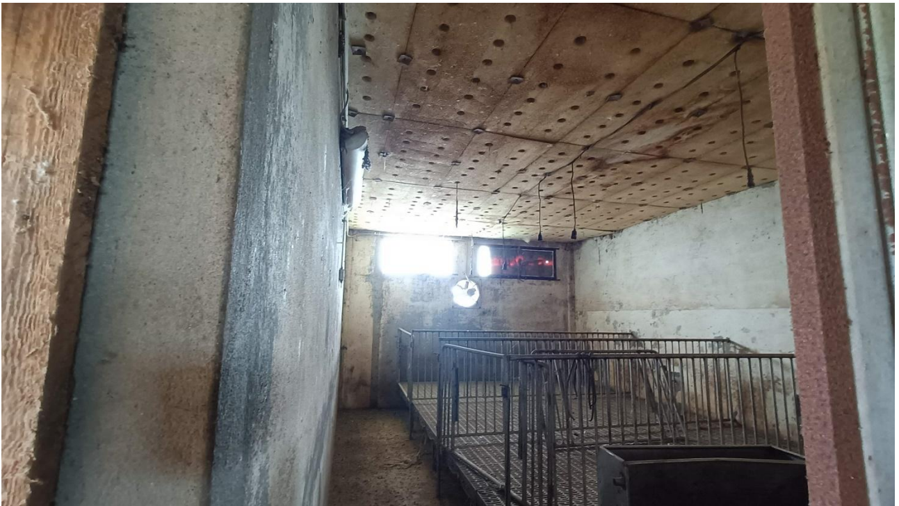
Foto n.74 edificio a destinazione stalla indicato con D nell'ortofoto, vista interna
