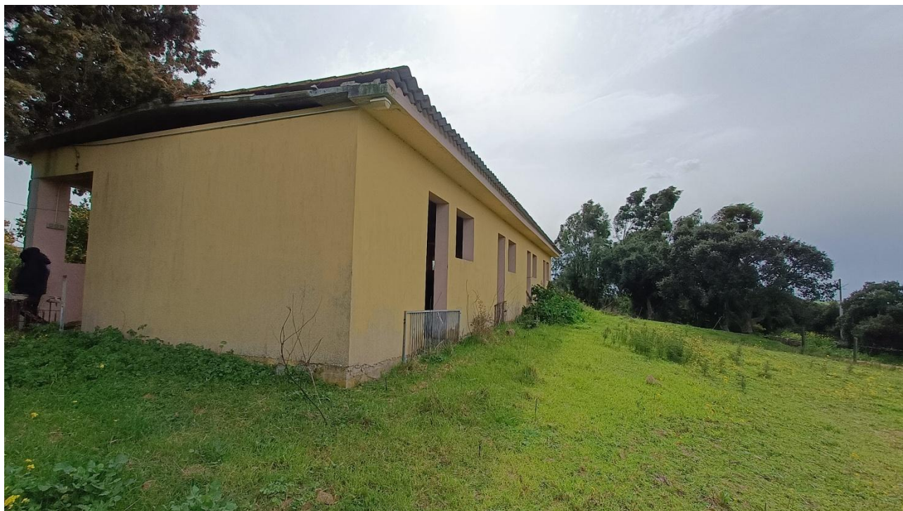
Foto n.56 – prospetto nord-ovest dell'edificio a destinazione scuderia indicato con B nell'ortofoto, vista esterna
